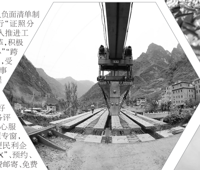
项目建设如火如荼。记者 张广玉 摄
